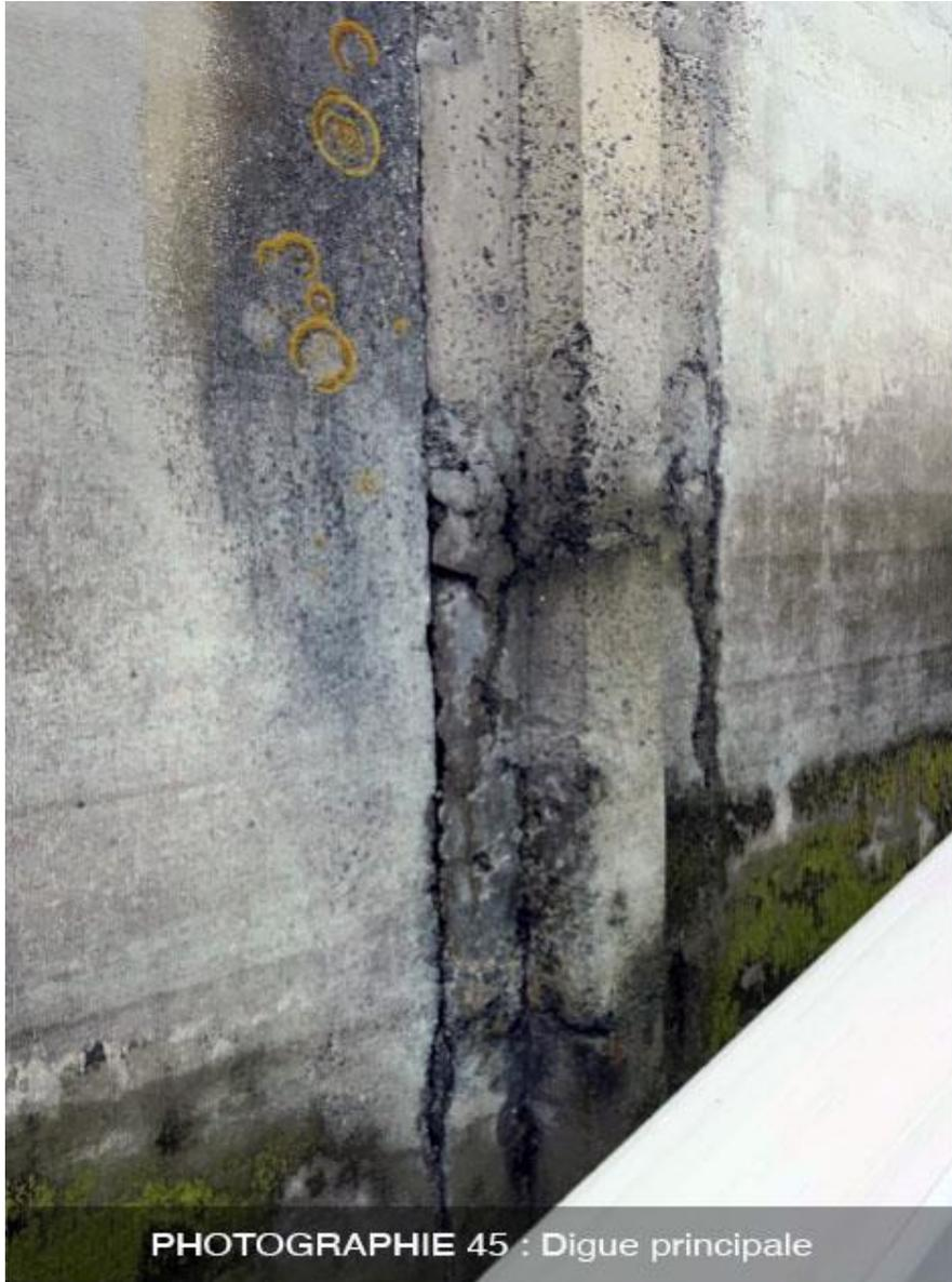
S'agissant des poutres ou entretoises de liaison des deux voiles des caissons de la digue principale, alors qu'aucun désordre ne les affectaient en 2020, des éclats de béton font apparaître aussi les armatures d'acier corrodées. Ces nouveaux désordres affectent un élément structurel de la digue, c'est-à-dire assurant sa solidité. (CF photographie n°21 ET 37)
